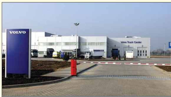
Obiekt w Pietrzykowicach to zupełnie nowy budynek, zaprojektowany i zbudowany zgodnie ze standardami Volvo w zakresie wyposażenia, troski środowisko i odpowiedniego przygotowania do spełniania określonych funkcji.
