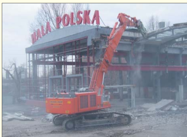
Podczas prac wyburzeniowych maszyny pracują w warunkach dużego zapylenia. Takie warunki pracy są wprost zabójcze dla układu chłodzenia. Dlatego operator powinien zawsze upewnić się, że jest on czysty
