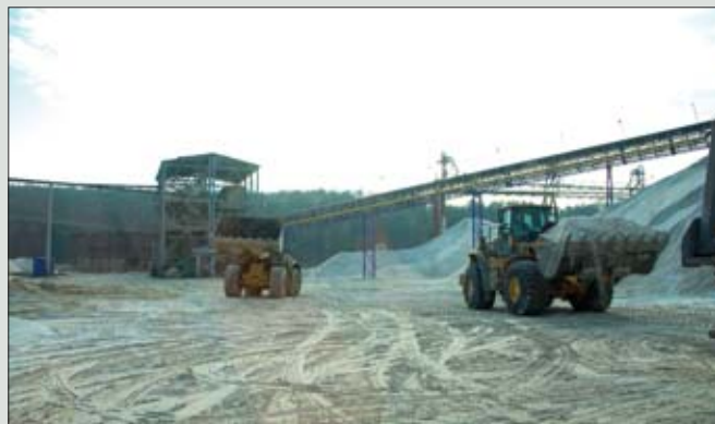
Maszyny ładują piasek i przemieszczają się po nim. Systemy automatycznego smarowania pomagają chronić ich zespoły robocze przed szkodliwym tarcieniem
