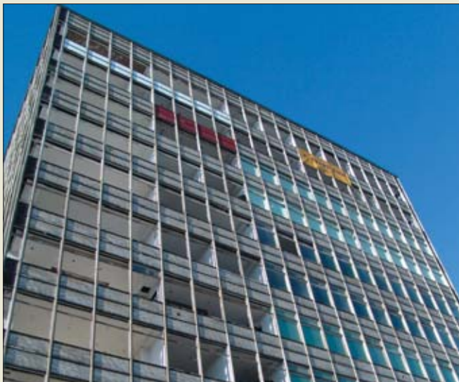
Wyburzenie w roku 2007 będącego jednym z symboli „Waryńskiego” biurowca przy ul. Kolejowej 57 zapowiadało definitywny koniec firmy
