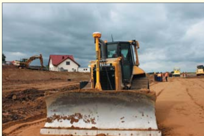
Operator spycharki po dwóch miesiącach pracy na maszynie wyposażonej w system sterowania 3D osiąga wydajność pracownika z kilkuletnim doświadczeniem
