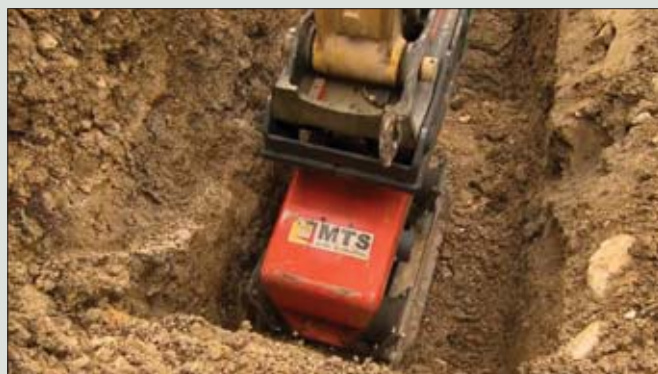
W czasie testów duży spadek zużycia paliwa odnotowano także podczas prac polegających na stabilizacji dna wykopów
