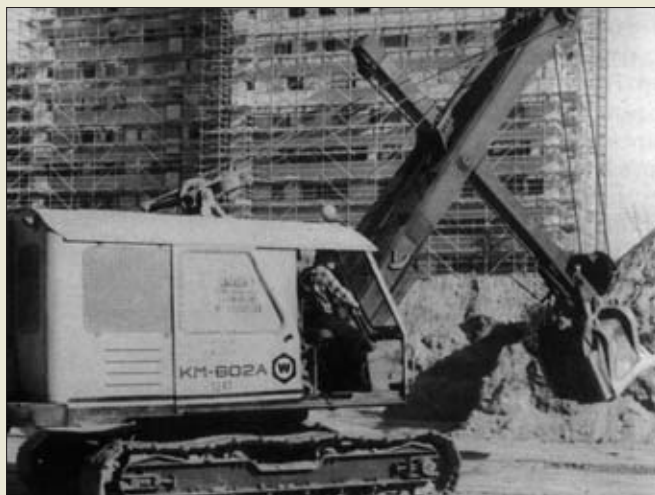
Kolejne modernizacje konstrukcji koparek mechanicznych sprawiły, że w roku 1964 światło dzienne ujrzała maszyna KM-602
