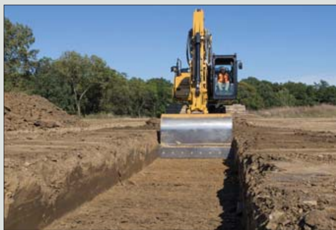
Integracja z układem hydraulicznym maszyny daje możliwość precyzyjnego sterowania ruchem łyżki, dzięki czemu operator uzyskuje wymaganą głębokość wykopu
