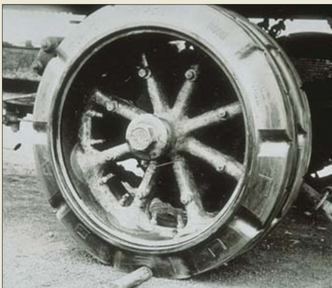
W roku 1919 Fulda uruchomiła seryjną produkcję Riesenkissenreifen, która bardzo szybko stała się wiodącą oponą ciężarową w Europie
