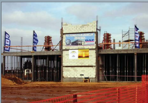
DAF Trucks Polska realizuje kolejną budowę obiektu serwisowego w Białymstoku. Rozpocznie ona swą działalność w drugiej połowie roku
