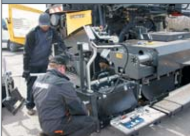
Montaż modułów poszerzających stół roboczy przebiega szybko i wymaga pracy tylko dwóch osób
