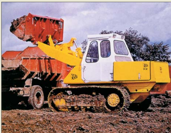
Prototyp innowacyjnej ładowarki gąsienicowej opracowano w roku 1968. Do seryjnej produkcji maszyna weszła na początku lat siedemdziesiątych ubiegłego stulecia
