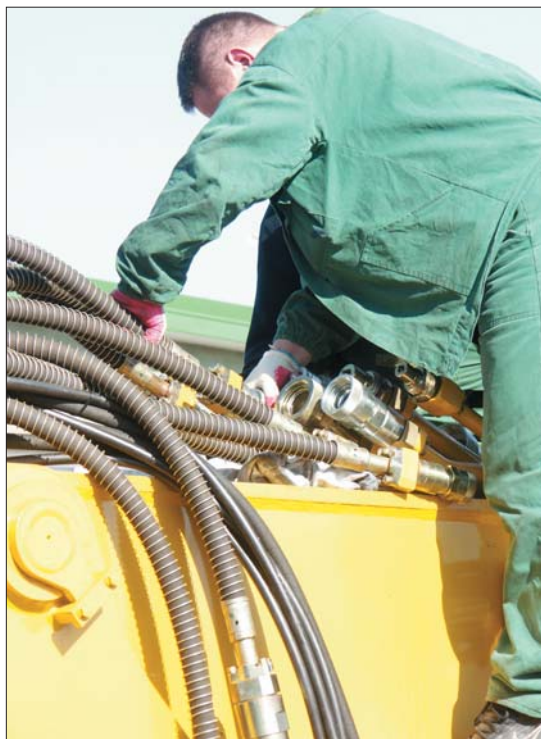
Do utrzymania niezawodności działania układu hydraulicznego konieczna jest kontrola stanu instalacji, połączeń rozłącznych oraz wysokociśnieniowych przewodów elastycznych
