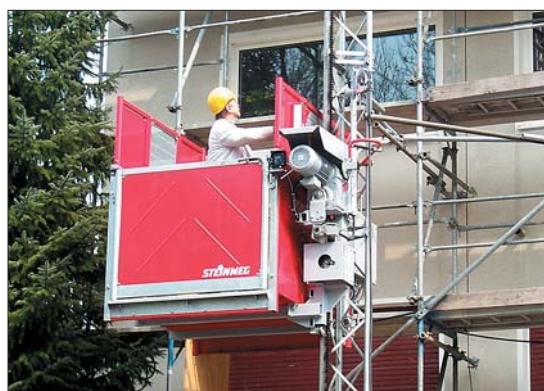
Superlift MX 924 to urządzenia wciągane na pojedynczym maszcie znakomicie sprawdzające się na placach budowy średniej wielkości.
