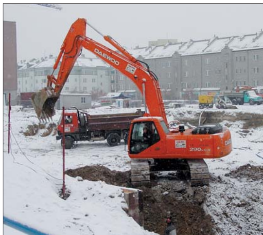
W okresie zimowym układy jezdne maszyn gąsienicowych są szczególnie narażone na uszkodzenia. Dlatego też powinny być po zakończeniu pracy gruntownie czyszczone
