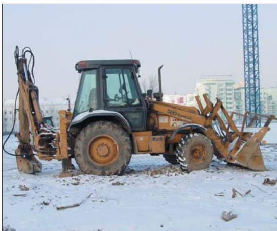
Przed powzięciem decyzji o eksploatacji maszyny w sezonie zimowym, właściciel powinien wziąć pod uwagę jej stan techniczny
