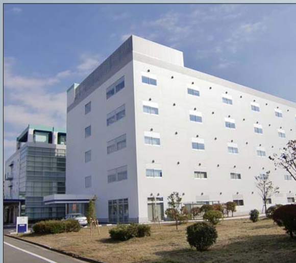
Zakłady Komatsu w Shonan produkują zaawansowane technologicznie podzespoły napędu hybrydowego koparki PC200-8
