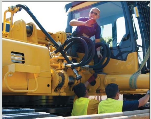
Montaż maszyny na terenie kopalni Miedzianka od samego początku przebiegał bez zakłóceń i został ukończony w przewidzianym terminie
