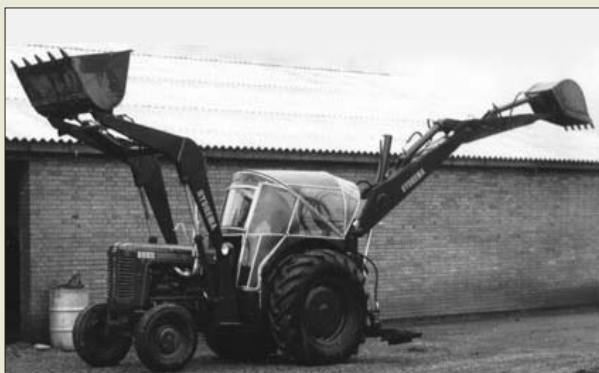
Na podstawie specjalnej umowy od roku 1964 Hydrema produkowała osprzęt roboczy wykorzystywany na duńskich ciągnikach Bukh
