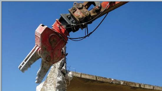
Dzięki zastosowaniu stali Hardox i Weldox oraz komponentów hydraulicznych uznanych marek nożyce Rotar cechują się bezawaryjnym działaniem i wydajnością
