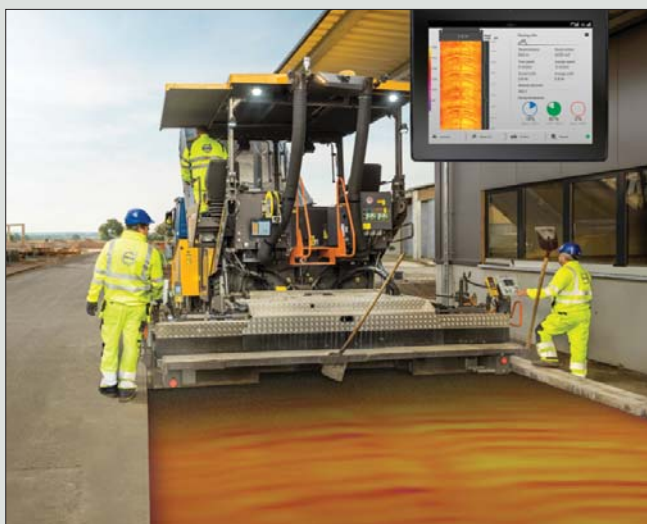
Pave Assist daje operatorom rozścielaczy dostęp do gromadzonych w czasie rzeczywistym informacji na temat jakości i wydajności prowadzonych prac
