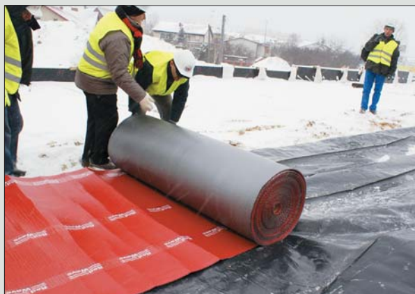
Przykrycie przewodu specjalnymi odpornymi na uszkodzenia mechaniczne i nadającymi się do wielokrotnego użytku matami izolacyjnymi sprawia, że ciepło zatrzymywane jest tuż przy podłożu
