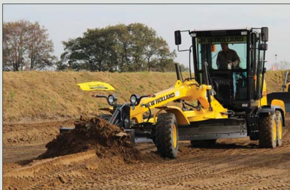
W celu zaprezentowania nieprzeciętnych możliwości równiarek drogowych New Holland na rozległym poligonie demonstracyjnym stworzono warunki typowe dla rzeczywistego placu budowy
