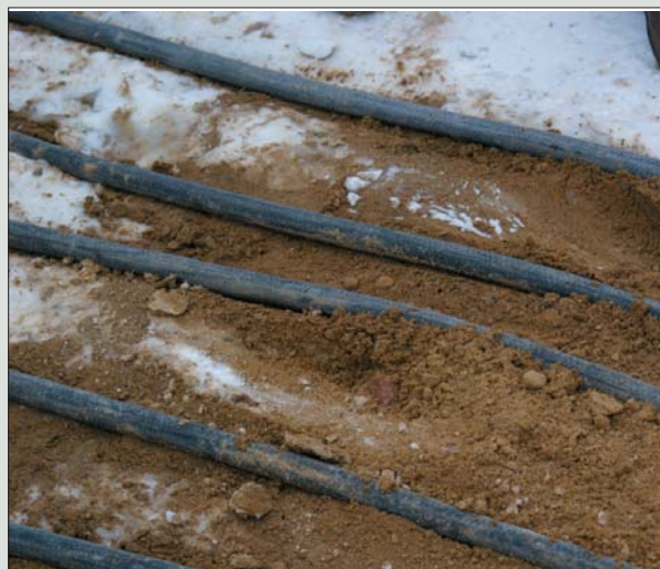
Podgrzewacz nawierzchni Wacker Neuson E700M okazał się niezwykle skuteczny. Mimo opadów śniegu i siarczystego mrozu umożliwił prowadzenie prac na miękkim podłożu wolnym od śniegu i lodu
