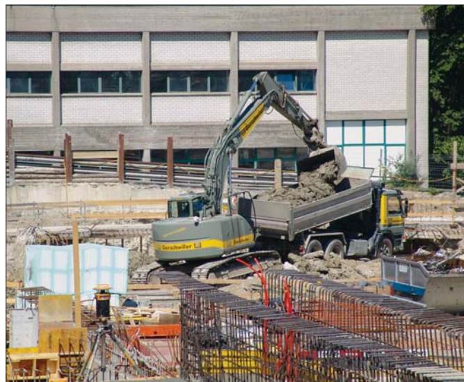
Miejski plac budowy w szwajcarskim Arbon. Znacznie surowsze niż w Unii Europejskiej przepisy sprawiają, że silniki wszystkich maszyn budowlanych pracujących w tym kraju muszą być już teraz wyposażone w układy ograniczające emisję spalin
