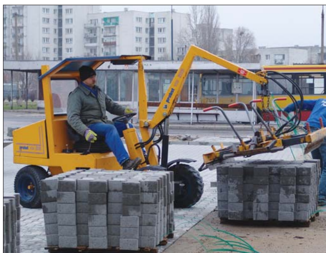
Mechaniczna układarka do kostki brukowej firmy Probst
