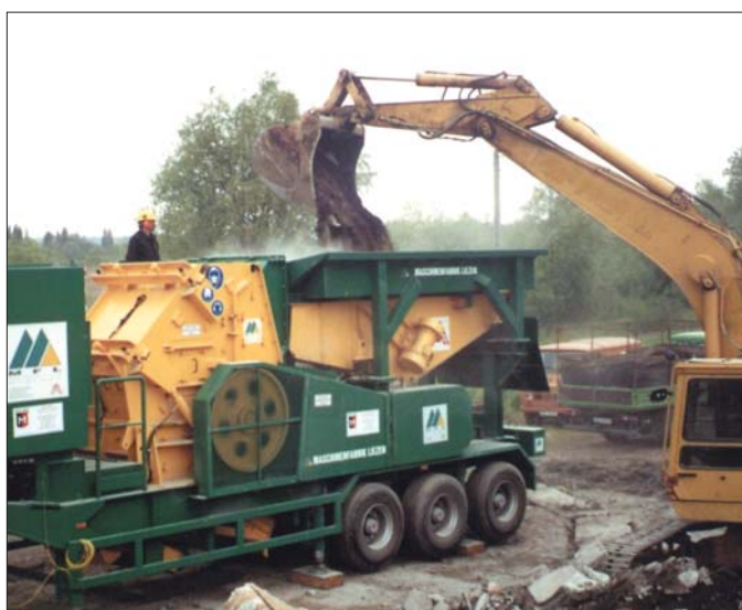
Zestaw recyklingowy na przyczepie niskopodwoziowej zasilany w materiał za pomocą koparki hydraulicznej. Ponieważ jego mobilność w miejscu pracy jest znacznie ograniczona, w celu optymalizacji procesu zasadniejsze podczas prac trwających dłużej jest stosowanie ładowarki kołowej
