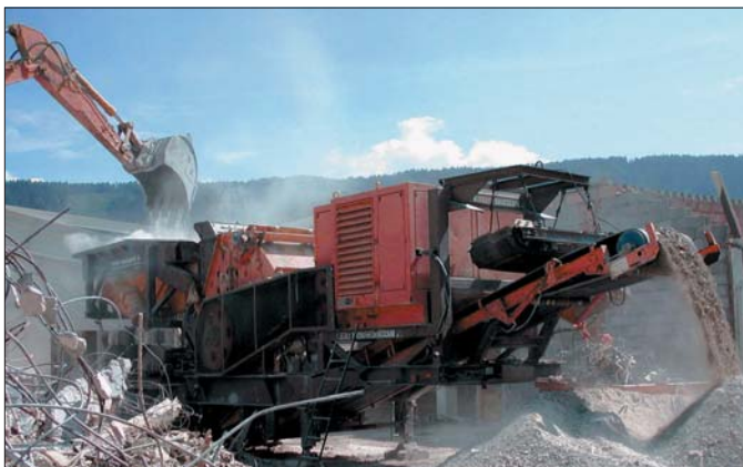
Koparka hydrauliczna dostarczająca materiał do kruszarki pracuje w pełni efektywnie wyłącznie w promieniu swego wysięgnika, jej przejazdy pociągają za sobą znaczne zwiększenie kosztów i wydłużenie czasu wykonania zadania
