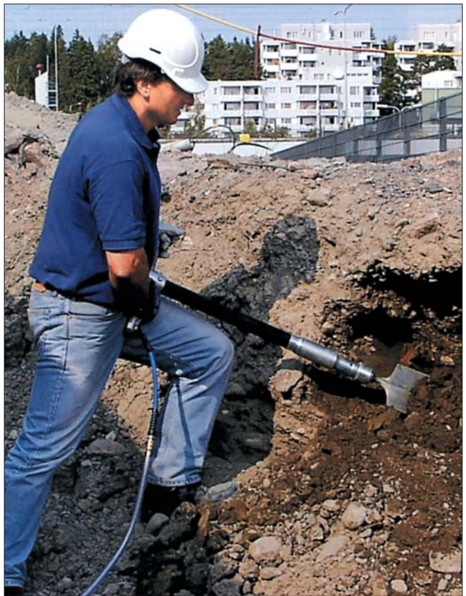
Choć dziś sama łopata nie wystarczy do budowania, ta o napędzie pneumatycznym może sprawić, że wykonywane ręcznie prace ziemne staną się mniej uciążliwe...
