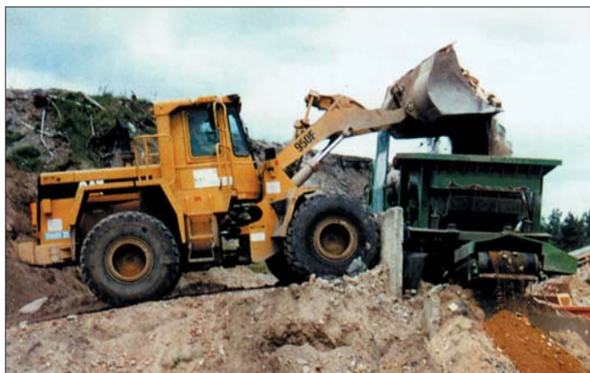
Gruz budowlany można dostarczać do kruszarki za pomocą ładowarki kołowej. Z reguły wiąże się to jednak z koniecznością budowania rampy umożliwiającej łatwiejsze dotarcie do zasobnika
