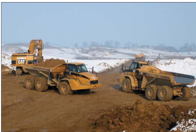
Na autostradzie A1 pracują też z powodzeniem wozidła przegubowe Caterpillar tworzące doskonale zsynchronizowane tandemy z koparkami tej firmy
