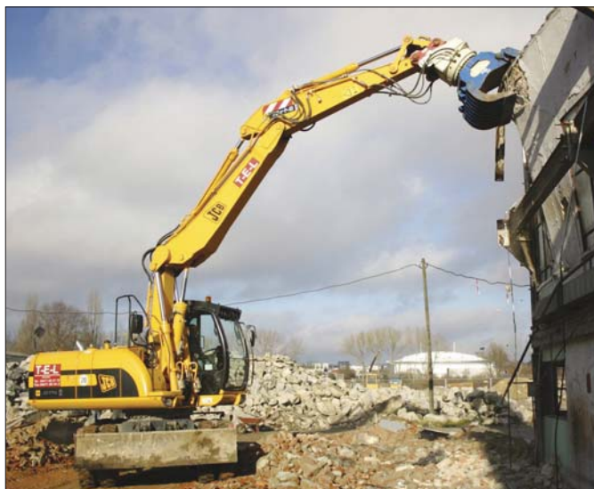
Koparka hydrauliczna wyposażona w odpowiedni osprzęt może nie tylko zasilać w materiał kruszarkę, ale wcześniej prowadzić prace rozbiórkowe i wyburzeniowe
