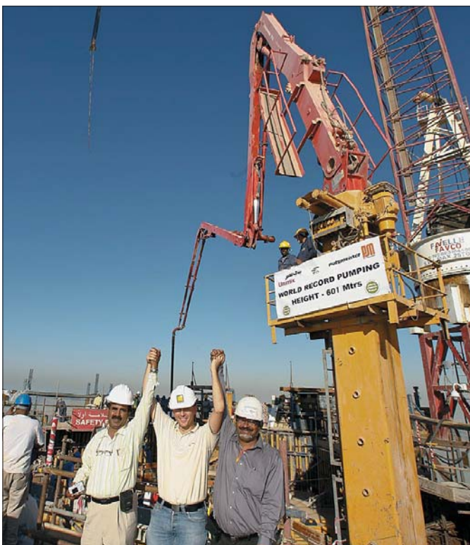
Pracownicy dostarczającej beton i obsługującej pompy Putzmeistera firmy Unimix świętują wraz z budowniczymi wysokościowca Burj Dubai ustanowienie nowego rekordu
