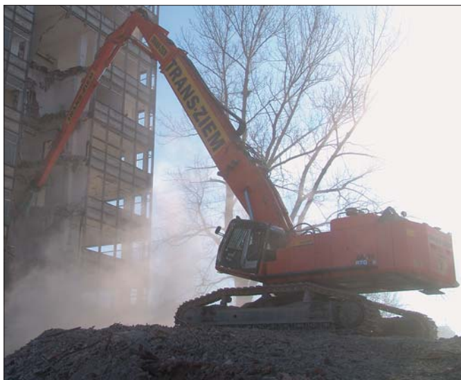
Odchylana kabina koparki przeznaczonej do wyburzeń pozwala operatorowi na wygodne obserwowanie pola robót. Specjalny system filtrów i zraszaczy chroni wnętrze kabiny przed wnikaniem tworzących się podczas pracy pyłów
