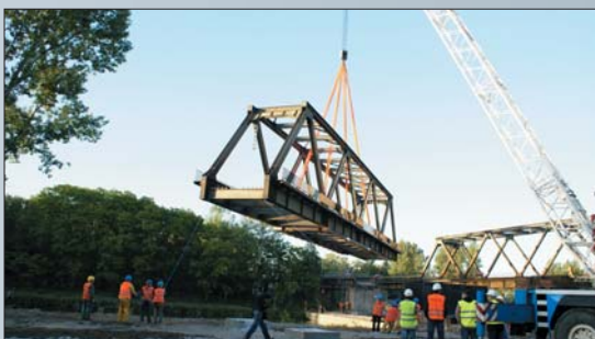
Akcja demontażu mostu rozpoczęła się w środku nocy, jednak zanim udało się nam zauważyć drgnięcie metalowego kolosa, nastał świt
