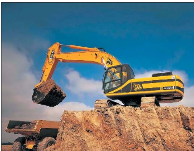
Przy budowie dróg wokół Soczi pracować będą także koparki gąsienicowe JCB JS 330
