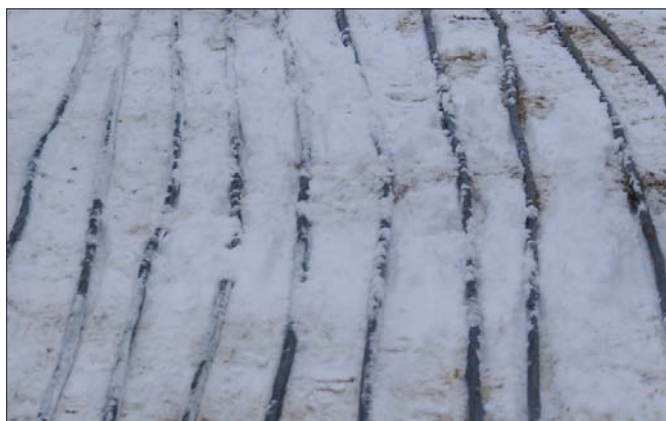
Wężę wypełnione gorącą mieszanką wody i glikolu układane są na rozmrażanej nawierzchni
