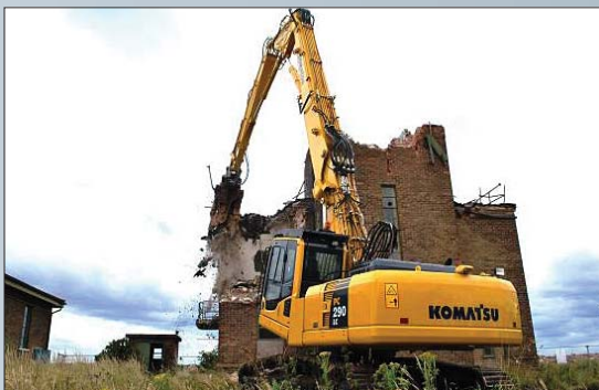
▲ Komatsu PC 290 LC/NLC-8 - nowa koparka do wyburzeń
