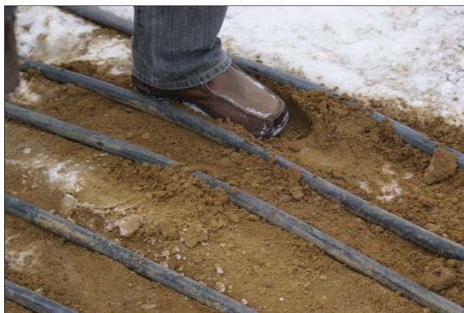
Po zdjęciu mat izolacyjnych odmrażana powierzchnia jest miękka i wolna od śniegu i lodu
