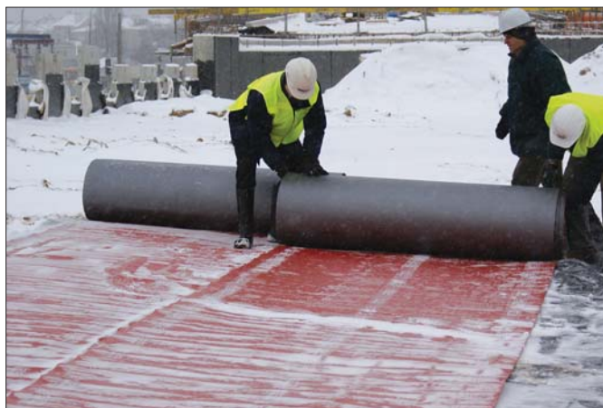
Przykrycie gorących wężów specjalnymi matami sprawia, że ciepło zatrzymywane jest przy podłożu
