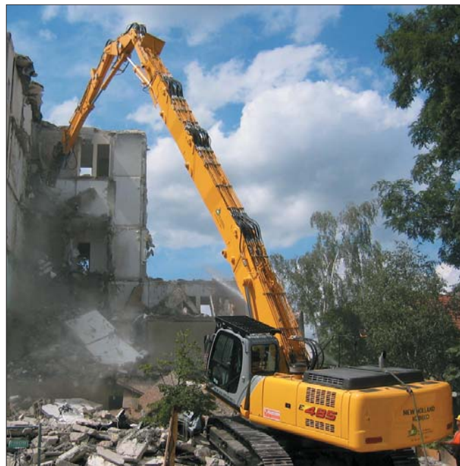
Koparka New Holland E485B potwierdziła swe zalety podczas prac wyburzeniowych prowadzonych w ekstremalnie trudnych warunkach
