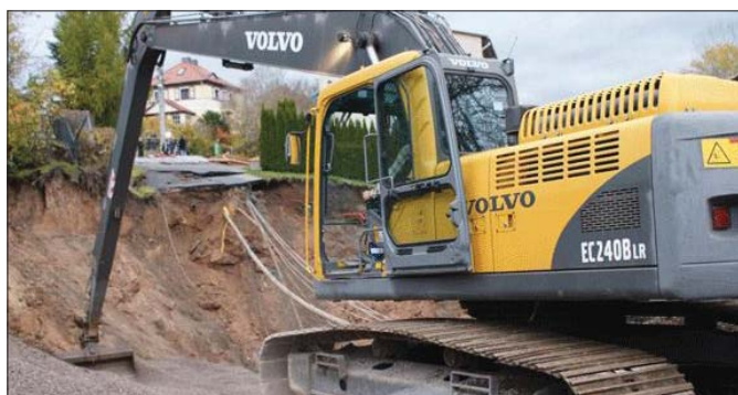
Operator pracował przy otwartych drzwiach kabiny, tak aby usłyszeć syrenę alarmową
