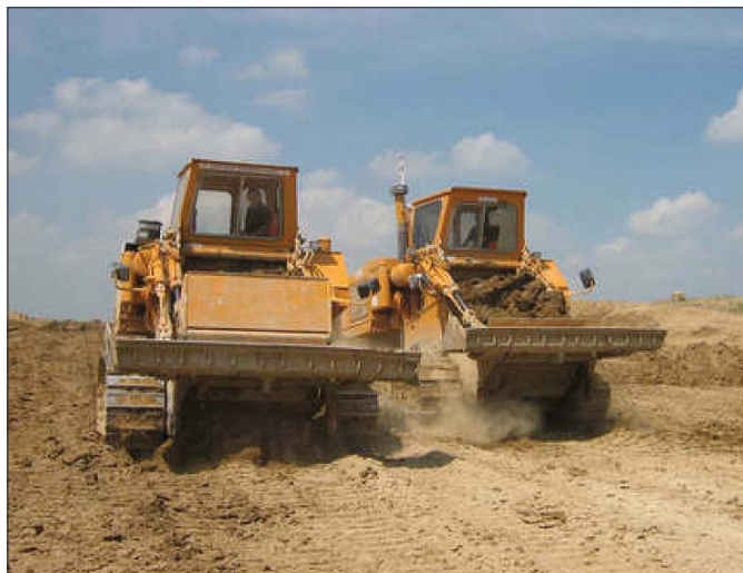
Spycharko-ładowarki Frutiger SR 2000 na budowie duńskiej autostrady
