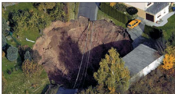
Widok z lotu ptaka doskonale ukazuje skalę katastrofy
