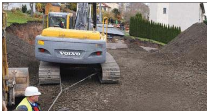
Jako dodatkowe zabezpieczenie zastosowano linę stalową połączoną z inną koparką
