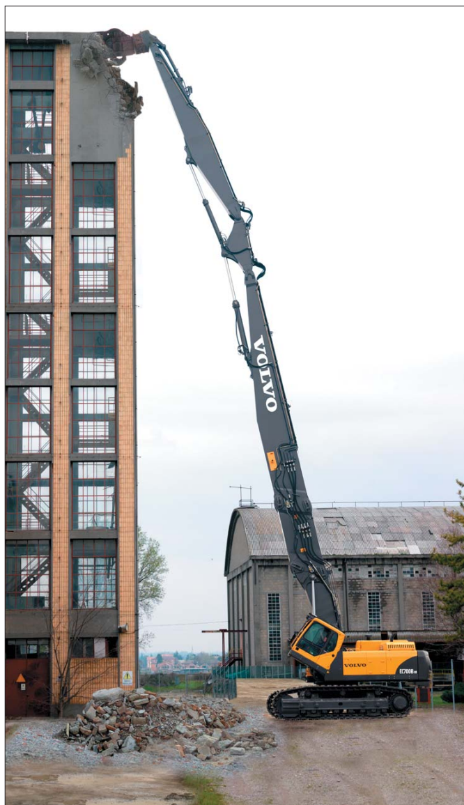
Powodzenie w pracach wyburzeniowych wymaga maszyn przystosowanych do ekstremalnych warunków i wydajnego osprzętu. Największa koparka wyburzeniowa oferowana przez Volvo CE wyposażona jest w wysięgnik o długości 32 metrów
