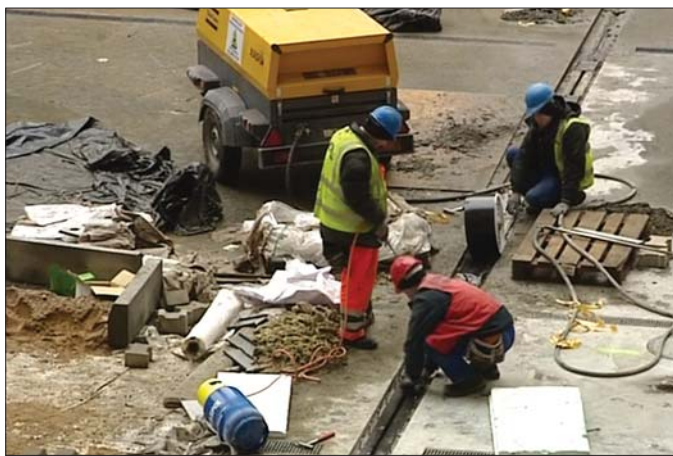
Oferowany przez firmę Ulisses program CoMoTel umożliwia rozliczenie elementów na placu budowy w trzy minuty
