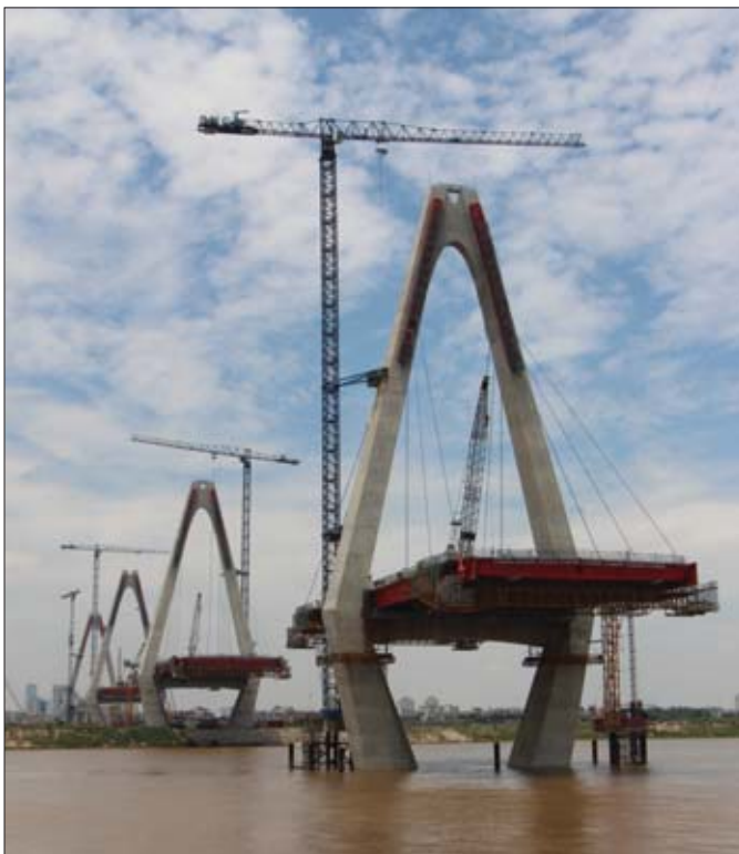
Wykonawca zapowiada, że Most Nhat Tan zostanie otwarty w październiku tego roku po sześćdziesięciu miesiącach budowy
