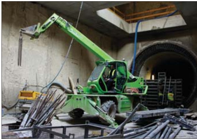
Maszyny wynajmowane przez firmę Adama Czeladzkiego pracują w wielu nietypowych miejscach, także pod ziemią na budowie drugiej linii warszawskiego metra...
