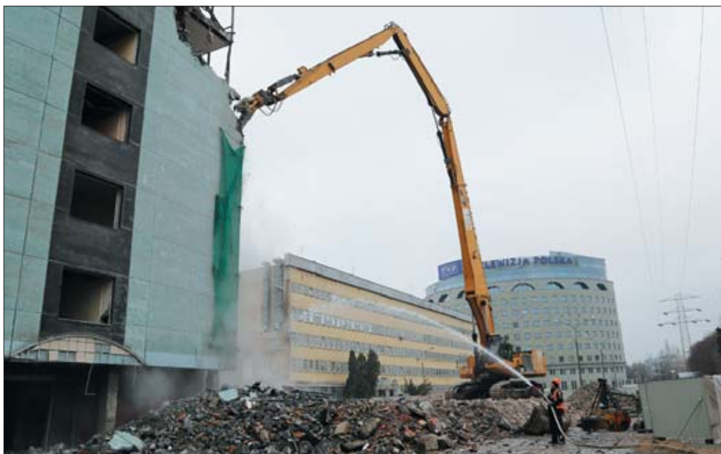
Najwięcej kurzu powstaje wcale nie przy odcinaniu gruzu, ale w momencie opadania odłamków, dlatego podłoże jest na bieżąco zraszane silnym strumieniem wody
