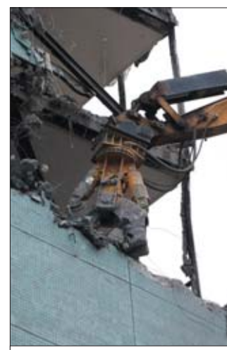
Na wstępnym etapie prac rozbiórkowych są stosowane nożyce wyburzeniowe
