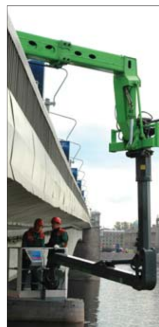
Wysięgnik z koszem umożliwia prowadzenie inspekcji napraw mostów i wiaduktów
