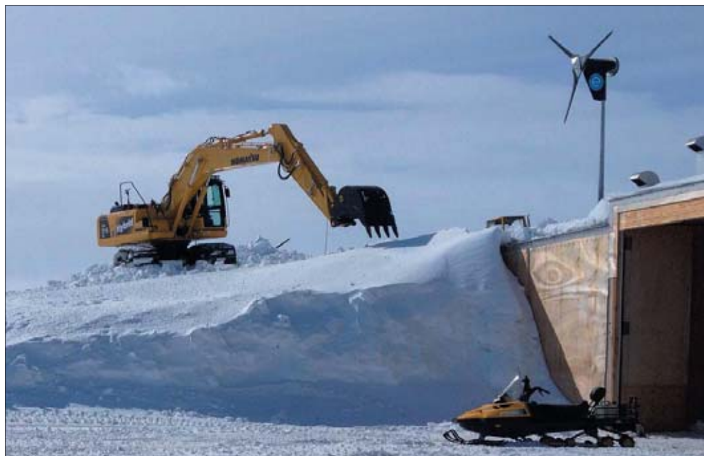
Koparka podarowana belgijskim polarnikom nie wymagała żadnych nadzwyczajnych przeróbek, ponieważ każda seryjna maszyna Komatsu przystosowana jest do pracy w niskich temperaturach
