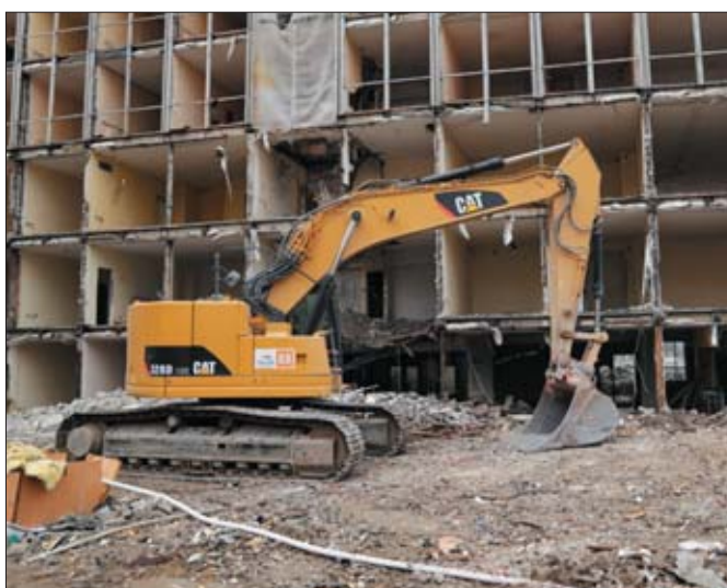
Każdej rozbiórce towarzyszą mniejsze maszyny pomocnicze, jak np. Cat 328 LCR, wykorzystywane na przykład do przygotowania podłoża pod koparkę Cat 385 UHD
