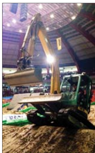
Minikoparki Yanmar pracowały przy budowie toru zawodów Supercross w dortmundzkiej Westfalenhalle
