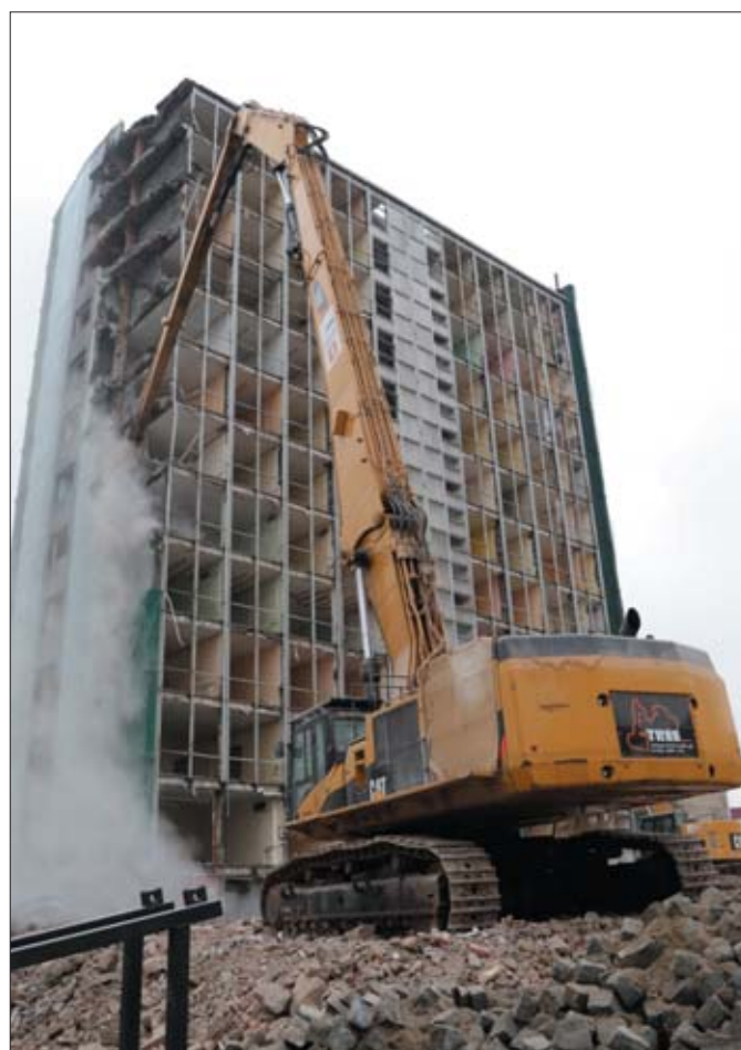
Unikatowa konstrukcja budynku sprawia, że musi być on rozbiórany od dołu do góry. W przeciwnym razie mogłoby dojść o niekontrolowanego zawalenia obiektu
