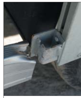
Brak odbojników gumowych lub dodatkowej listwy przeciwwjazdowej powoduje kolizję burty z aluminiowym profilem
