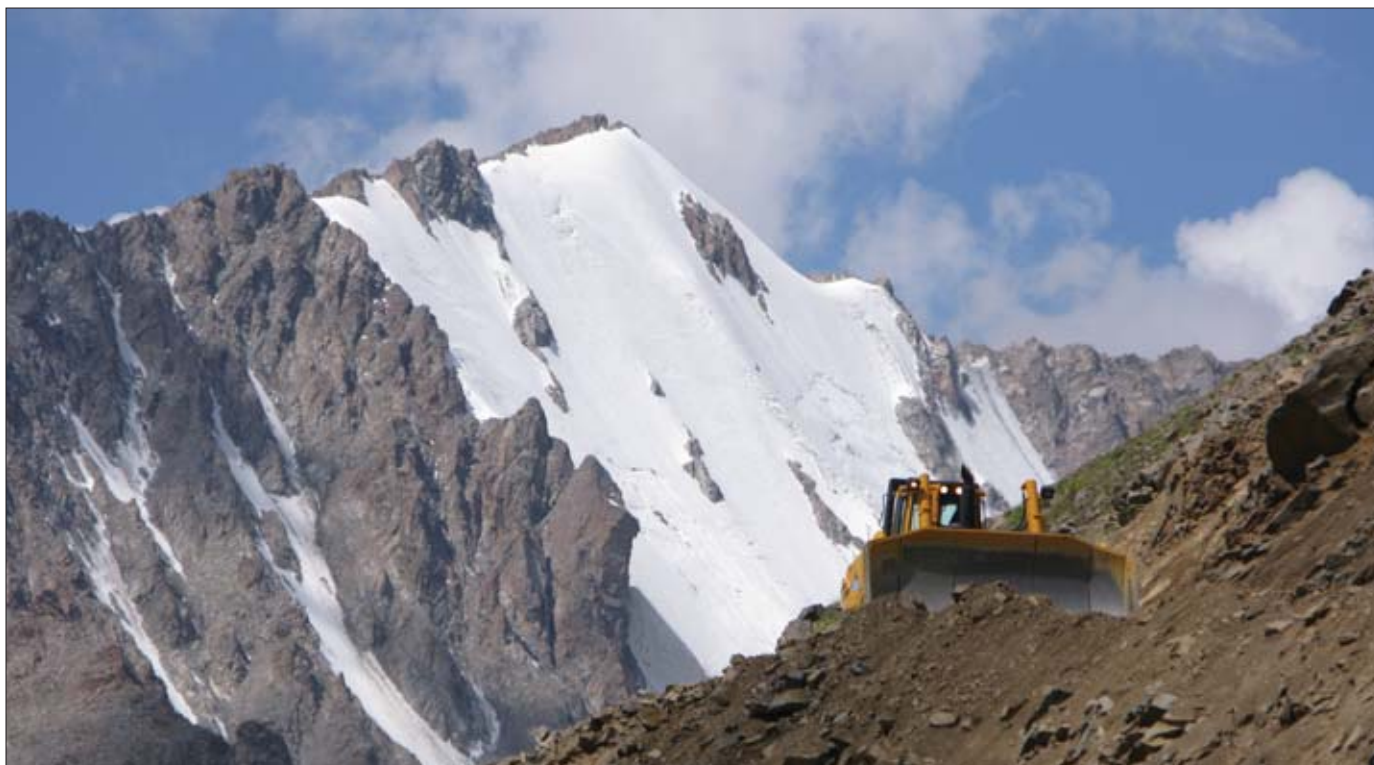
W roku 2007 w zachodnim Kirgistanie niedaleko miasta Tałas, firma „Dżeruj Altyn” rozpoczęła budowę nowej kopalni złota. Zadanie maszyn Dressta wykorzystywanych w realizacji tej inwestycji polegało w pierwszej kolejności na wykonaniu dróg dojazdowych do sztolni oraz utworzeniu placu poprzez ścięcie wierzchołka góry
