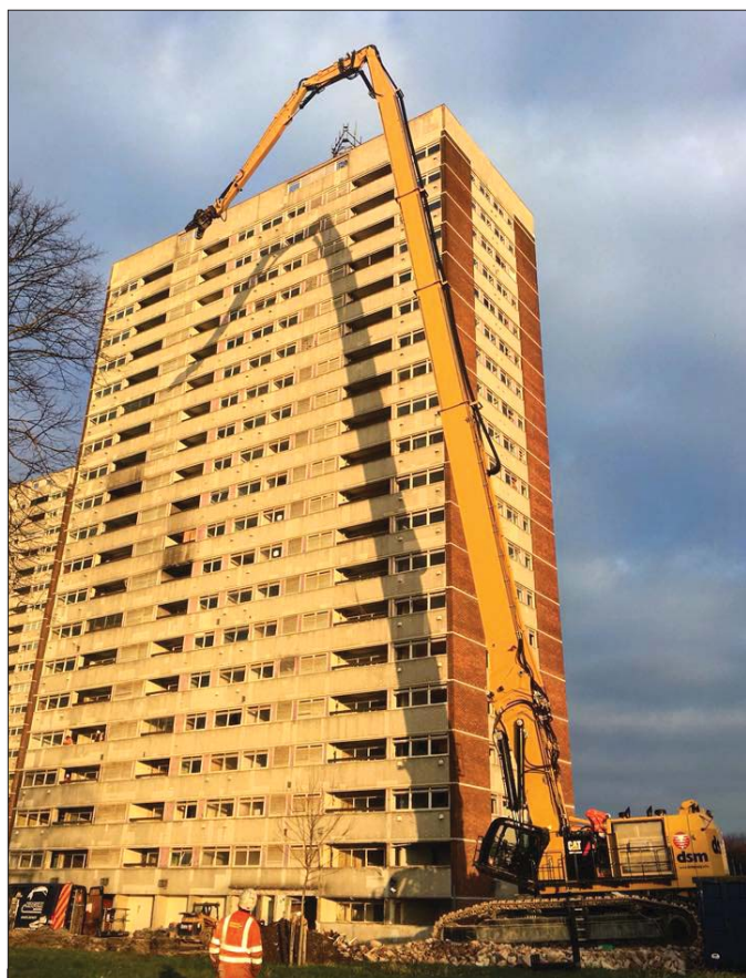
Pierwsza w Wielkiej Brytanii koparka wyburzeniowa z siedemdziesięciometrowym wysięgnikiem została zmodyfikowana przez firmę Kocurek Excavators
