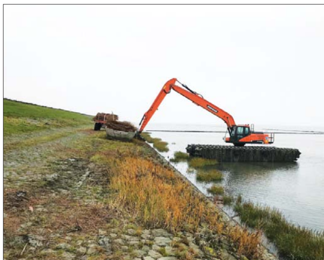
Koparkę doposażono w specjalistyczne wysięgniki typu long reach zwiększające zasięg, umożliwiając tym samym wybieranie materiału spod lustra wody
