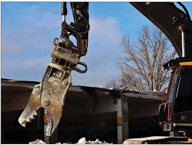
Roboty prowadzone były przy użyciu koparek hydraulicznych wyposażonych w specjalistyczny osprzęt wyburzeniowy marki MBI
