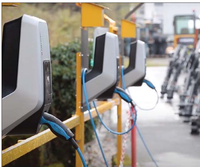
„Tankowanie” maszyn prądem elektrycznym przyczynia się do zmniejszenia emisji spalin i hałasu wpływających negatywnie na zdrowie i jakość życia
