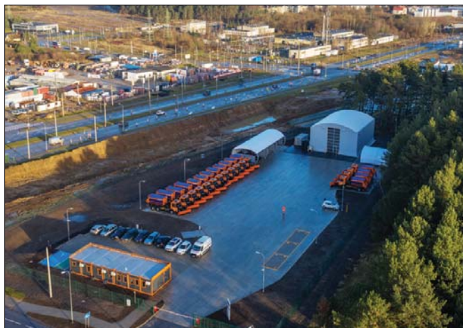
Maszyny Manitou pracują na terenie pierwszej bazy technicznej Letniego i Zimowego Utrzymania Dróg przy ulicy Starochwaszczyńskiej w Gdyni
