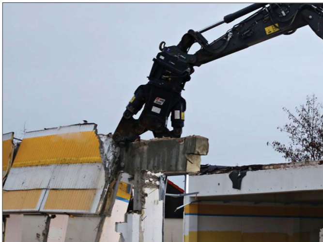
Odrywane od konstrukcji elementy z betonu komórkowego były następnie dzielone na mniejsze kawałki za pomocą specjalistycznych nożyc MBI
