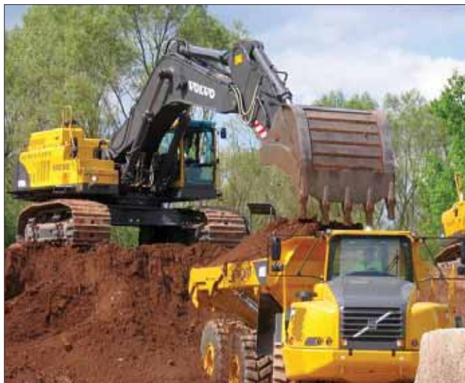
Dzierżącej zaszczytne miano flagowego modelu koncernu Volvo koparka EC700B LC stanowi zgrany tandem z wozidłami Volvo spotykanymi na wielkich budowach całego świata
