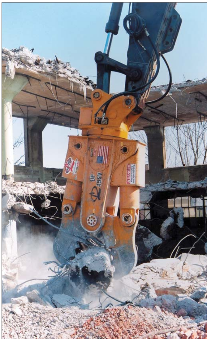
Urządzenia LaBounty zapewniają wysoki komfort pracy dzięki niskiemu poziomowi generowanego hałasu i drgań. Zastosowanie urządzeń LaBounty przy pracach rozbiórkowych i wyburzeniowych pozwala wykonać je dużo szybciej niż przy zastosowaniu młotów wyburzeniowych
