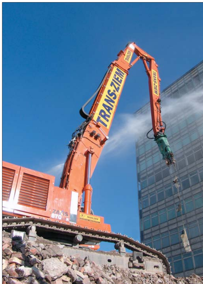
Krakowskie Przedsiębiorstwo Robót Inżynieryjnych Trans-Ziem pochwalić się może największą w Polsce maszyną wykorzystywaną do robót wyburzeniowych. Należąca do nowej generacji koparek hydraulicznych Hitachi, maszyna typu Zaxis 870 została wyposażona przez znaną brytyjską firmę Kocurek specjalizującą się w produkcji osprzętu do wyburzeń
