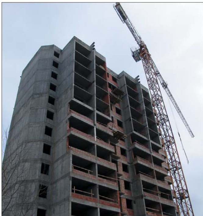
Place budowy w wielu miejscach świecą pustkami, tymczasem w rejestrach urzędów pracy odnotowanych jest ponad 260 tysięcy bezrobotnych pracowników budowlanych...
