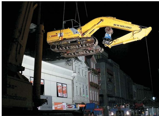
Ważąca blisko czterdzieści ton koparka New Holland E 385 bez najmniejszych problemów została przetransportowana za pomocą żurawia na dach rozbieranego obiektu...
