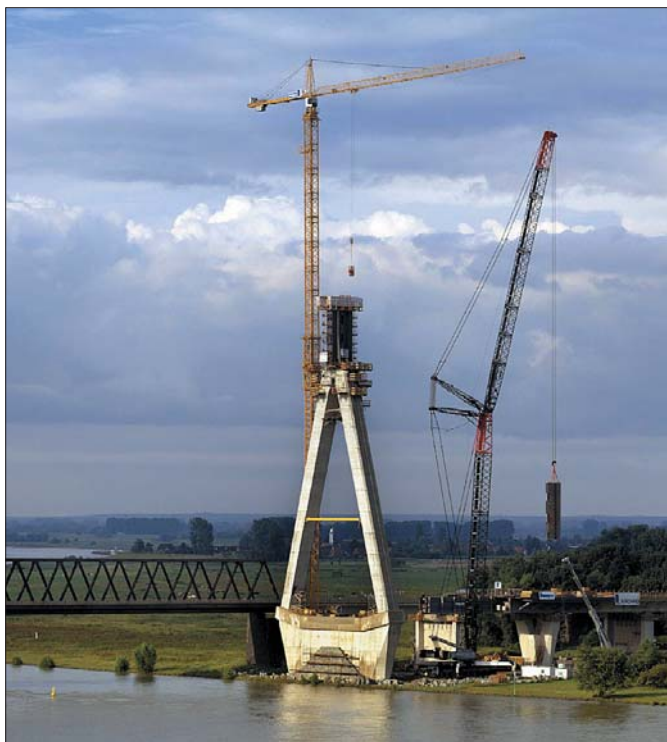
Podczas wznoszenia wysokiego na 130 metrów pylonu mostu na Renie w niemieckim Wesel wykorzystano dwa żurawie Liebherr o różnorodnej konstrukcji
