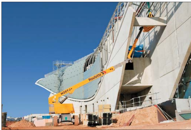
Dzięki unikatowemu ramieniu teleskopowemu platforma H28TJ+ oferuje użytkownikom możliwości, jakich nie ma inna platforma tego typu - 6 m. dodatkowego wysięgu.
