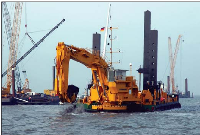
Koparka P 995 Litronic napędzana jest silnikiem Diesla o imponującej mocy 2.140 KM
