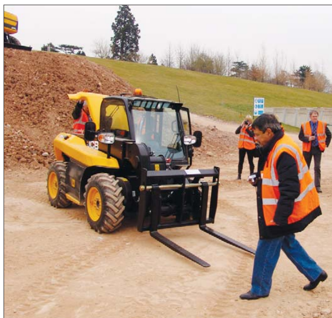
JCB 515-40 dzięki swym małym gabarytom idealnie sprawdza się podczas prac w ciasnej miejskiej zabudowie, a nawet we wnętrzach budynków
