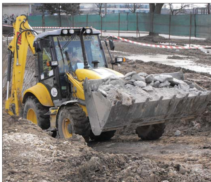
Odpady powstałe w wyniku prac były transportowane w tyłce ładowarkowej na znajdujące się w pobliżu zwalowisko
