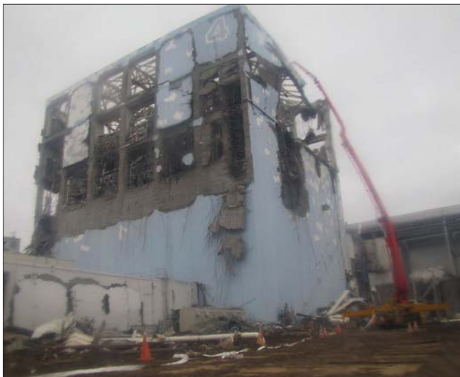
Pompa Putzmeister M58-5 podczas schładzania wodą bloku reaktora numer 4
