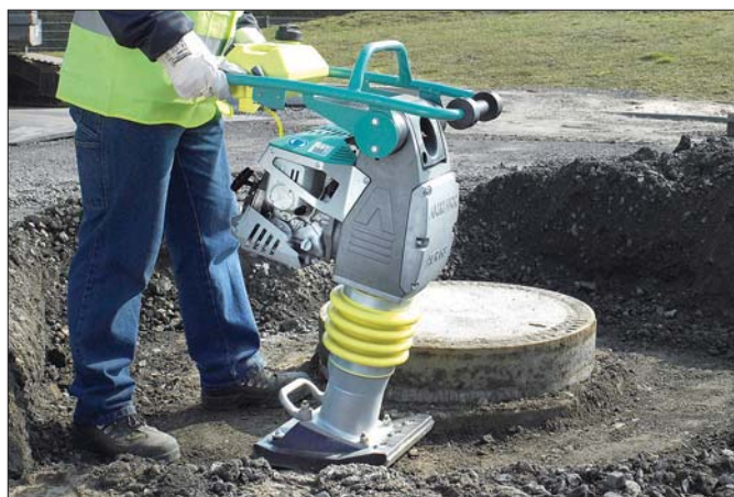
Skoczek ACR 60 dzięki nisko osadzonemu środkowi ciężkości, który uzyskano poprzez dolne usytuowanie silnika, jest wyjątkowo stabilny i ergonomiczny
