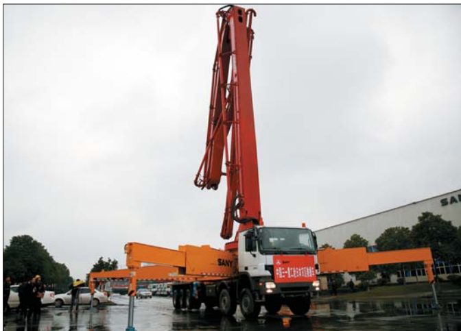
Zamontowana na podwoziu ciężarowym pompa Sany dzięki swemu wyjątkowemu wysięgowi może pomóc w precyzyjnym i skutecznym polewaniu reaktora wodą
