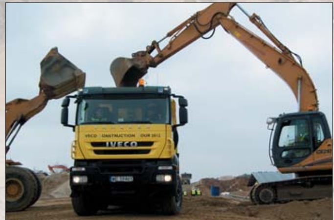
Partnerami trasy Iveco Construction Tour są: Intrac (dealer Case) z reprezentacją maszyn nadających się doskonale do pracy w żwirowniach
