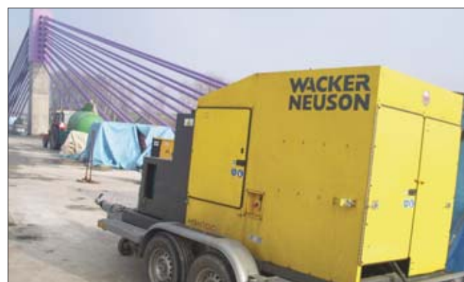
Budowa mostu na węźle Świerklany-Gorzyczki w ciągu autostrady A1. Prace mogły być kontynuowane dzięki zastosowaniu unikatowej technologii Wacker Neuson
