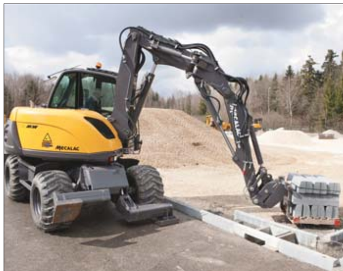
Mały promień zachodzenia tyłu przy obrocie umożliwia pracę koparki Mecalac 714 MWe w obrysie jednego pasa jezdni bez konieczności wstrzymywania ruchu
