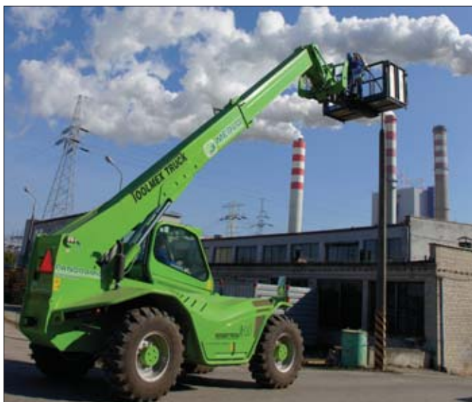
Kosz pozwala na bezpieczną pracę na wysokości podczas prac instalacyjnych i remontowych na rozległym terenie elektrowni. Zaletą ładowarki jest również to, że może być wykorzystywana z koszem bez przednich podpór
