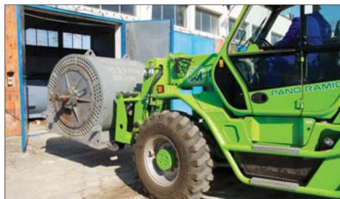
Maszyna doskonale radzi sobie z przemieszczaniem ciężkich ładunków, takich jak widoczny na zdjęciu ważyący 5.600 kilogramów silnik elektryczny. Wkrótce wykorzystywana będzie szerzej do innych zadań, na przykład prac instalacyjnych
