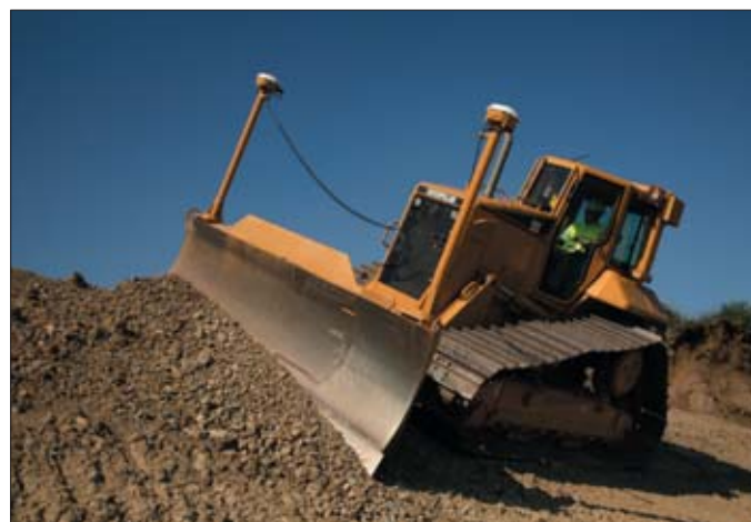
Na wykonanie zadania maszyna z systemem GCS900 3D potrzebowała niespełna półtorej godziny i zaledwie sześćdziesięciu przejazdów
