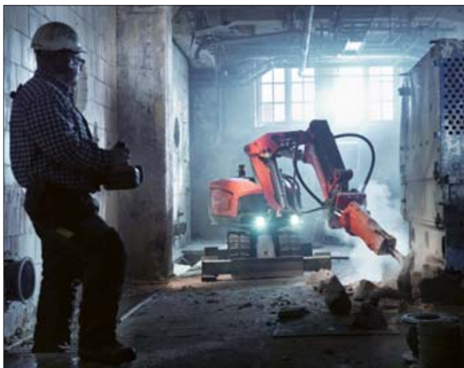
Stosunkowo mały ciężar i kompaktowe gabaryty sprawiają, że robotami bezproblemowo manewruje się w miejscach o ograniczonej przestrzeni
