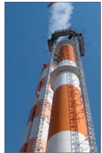
Zespół czterech podestów PW-18 ze skośnymi pomostami tworzący okrąg wokół remontowanego komina
