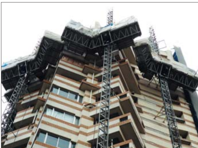
Każdy z podestów można dodatkowo wyposażyć w sekcje rozbudowujące umożliwiając tym samym dostosowanie jego kształtu do profilu elewacji budynku
