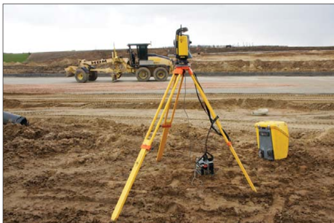
System Trimble typu GCS 900 redukuje liczbę przejazdów równiarki, a operator nie potrzebuje pomocy ze strony innych pracowników
