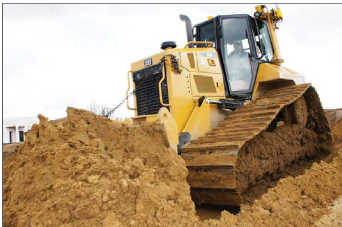
Zarówno spycharka, jak i system Trimble Earthworks egzamin zdawały – z pozytywnym skutkiem – w ciężkich warunkach na budowie nowej drogi ekspresowej
