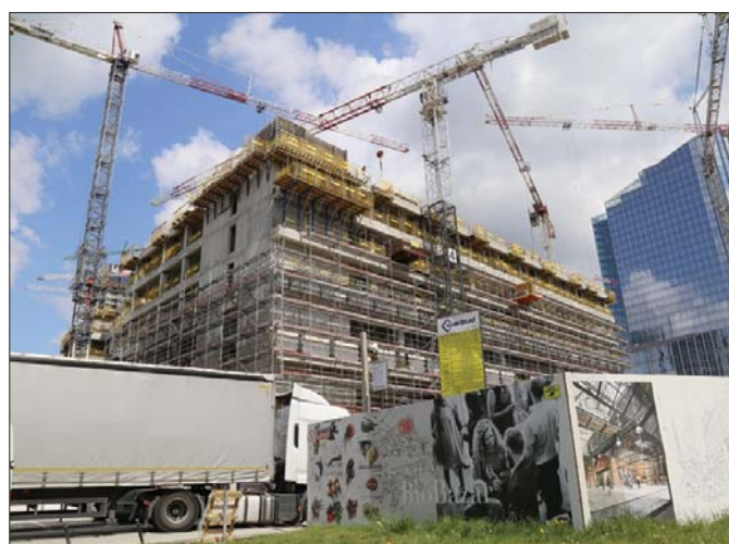
Centrum Warszawy to miejsce, nad którym górują budowlane żurawie. Dodajmy, że pracujące! Trwają dostawy materiałów budowlanych, roboty toczą się od rana do nocy
