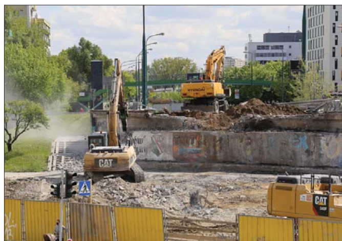
Na jeździe z kluczowych tras stolicy – Trasie Łazienkowskiej – trwa remont wiaduktów. Prace wyburzeniowe wymagały zamknięcia przejazdu, co obecnie było o wiele łatwiejsze
