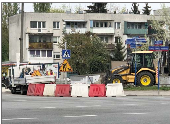
W czasie mniejszego ruchu samochodowego z powodzeniem dało się prowadzić uciążliwe w normalnych czasach prace komunalne, na przykład remont zatoczek autobusowych
