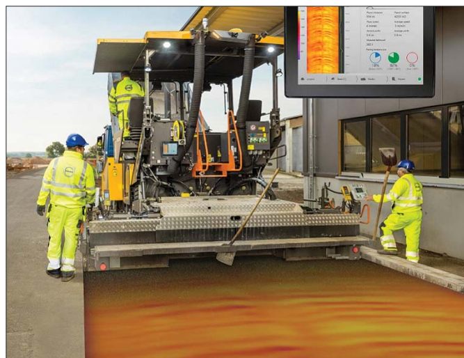
Narzędzie Thermal Mapping monitoruje temperaturę rozścielanej mieszanki bitumicznej. Jest to jeden z kluczowych czynników decydujących o jakości nawierzchni
