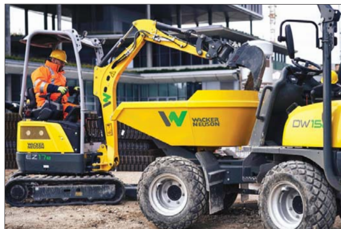
Maszyny budowlane o zerowej emisji firmy Wacker Neuson doskonale sprawdziły się na placu budowy w ścisłym centrum Wiednia
