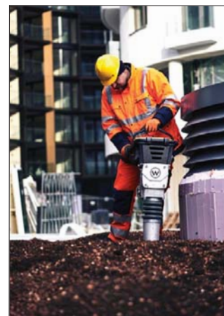
Elektryczny ubijak jest mniej hałaśliwy i nie emituje szkodliwych spalin
