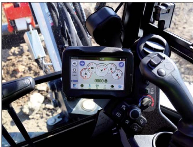
Czytelny monitor zaistalowany w kabinie to swoisty „panel dowodzenia” maszyną. Operator korzysta z niego praktycznie przez cały czas
