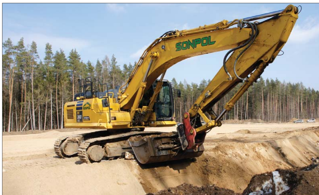
Łyżki skarpowe produkcji Dekpol Steel ze względu na swe walory cieszą się uznaniem firm z branży budownictwa drogowego. Spółka Sonpol obecnie używa ich na budowie drogi ekspresowej Via Baltica, między innymi do formowania skarp
