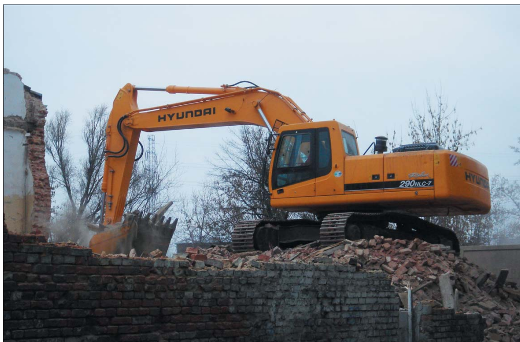
Hyundai 290LC-7 podczas prac rozbiórkowych na warszawskiej Pradze-Północ
