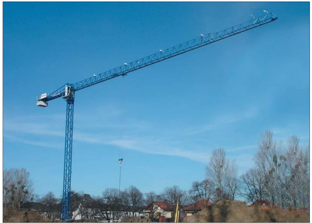
Żurawie Comansa już pracują na polskich placach budowy. Najpierw pojawiły się w Gdańsku, potem także w Olsztynie i Ostródzie
