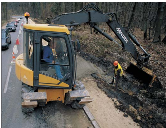
MECALAC zajmuje tylko jeden pas jezdni nie tamując ruchu w przeciwnym kierunku
