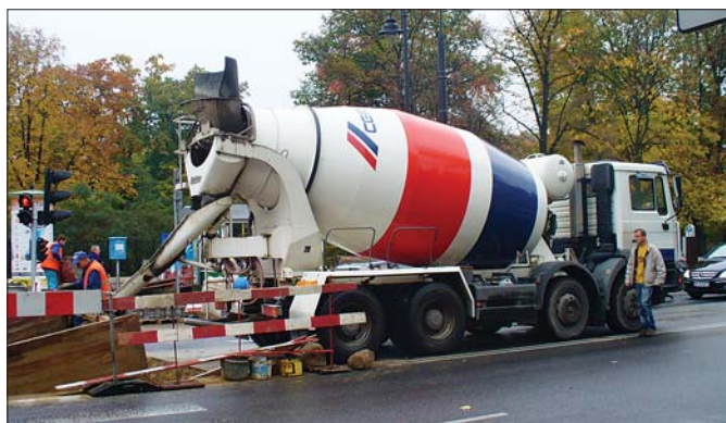
Wypełnianie nieczynnego kanału Al. Ujazdowskie, Warszawa
