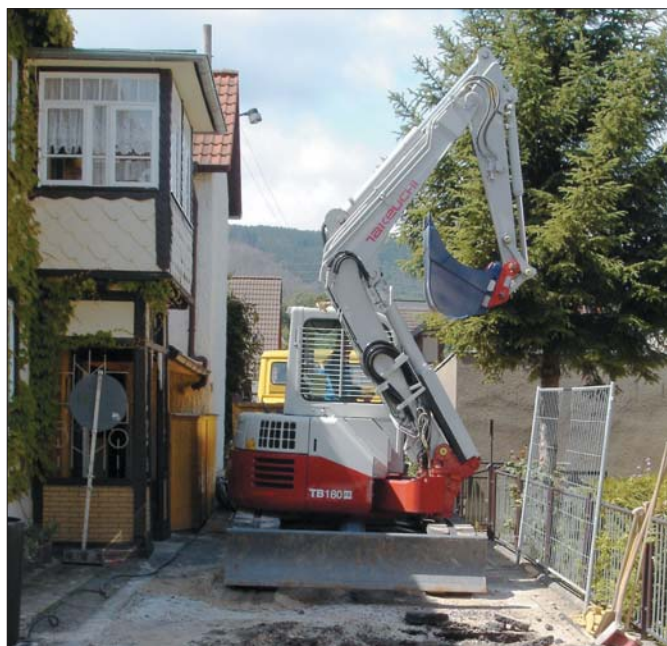
Jednym z priorytetów konstruktorów koparek Takeuchi było rozwiązanie problemu braku miejsca na placu budowy
