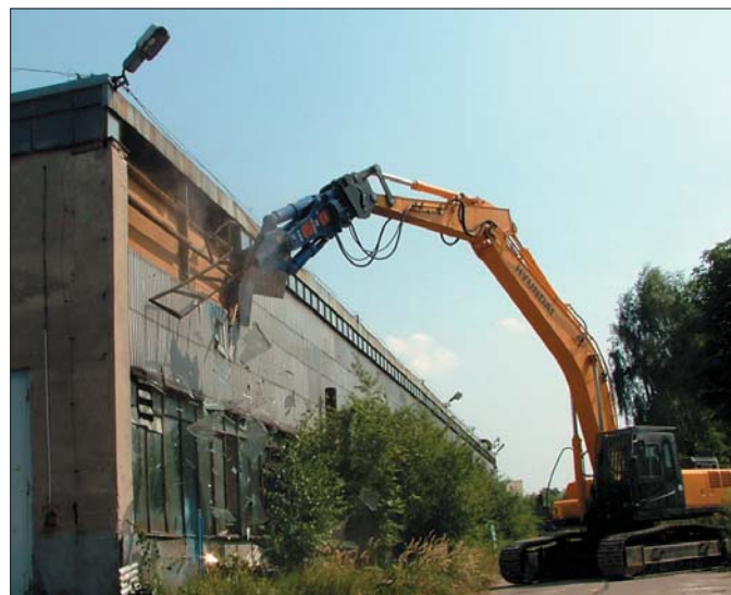
Ważące 2,5 tony nożyce MP 250 zamontowano na koparce gąsienicowej Hyundai 320LC-7A
