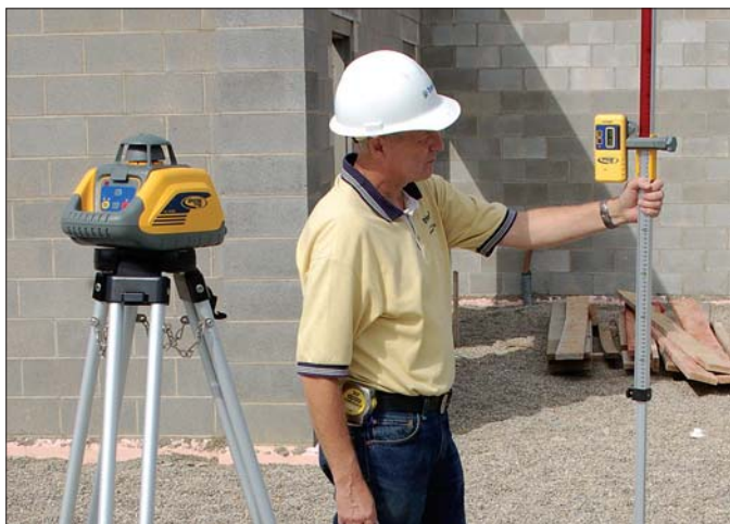
Wszechstronność urządzenia zapewnią funkcja ręcznego pomiaru nachylenia w jednej osi, wykorzystywana do wytyczania dróg dojazdowych, podjazdów i linii kanalizacyjnych
