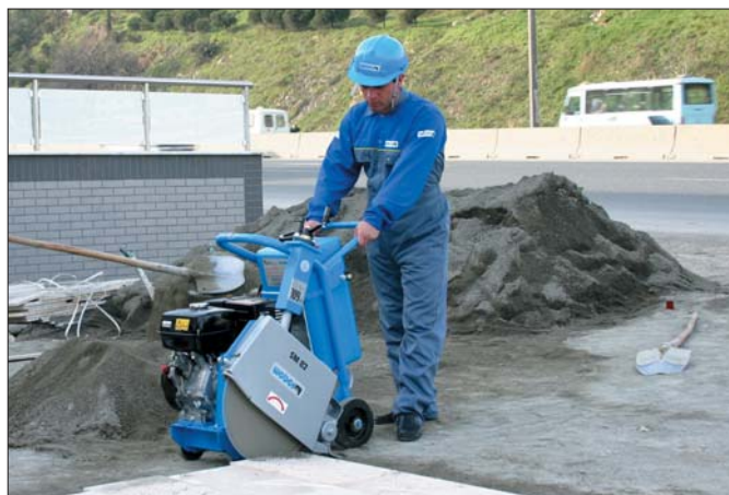
Weber MT oferuje trzy modele przecinarek jezdnych. Największa z nich, SM 82-2 umożliwia cięcie do głębokości 165 milimetrów
