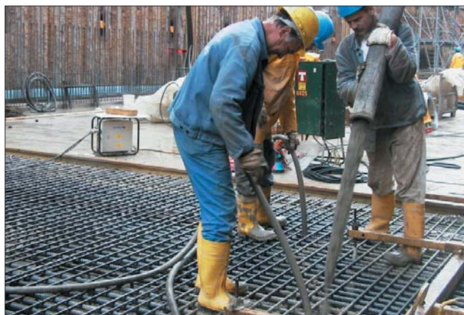
Dobór zestawu do wibrowania betonu uzależniony jest od zakresu wykonywanej pracy, rodzaju konstrukcji i gęstości zbrojenia
