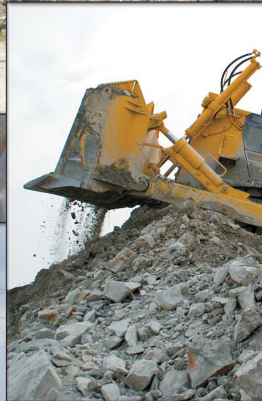
▲ Spycharka gąsienicowa Komatsu D475A, to największa maszyna tego typu pracująca w Polsce. Mimo że na zdjęciu wygląda całkiem niepozornie waży prawie 110 ton, ma przeszło 11.5 metra długości i blisko 5 metrów wysokości
