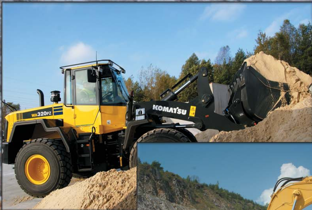
▲ Ładowarka WA320 pracuje w nowo powstałej betoniarni firmy Lafarge Kruszywa i Beton w Kielcach. Ładowarka dostarcza piasek i żwir do mieszalnika
