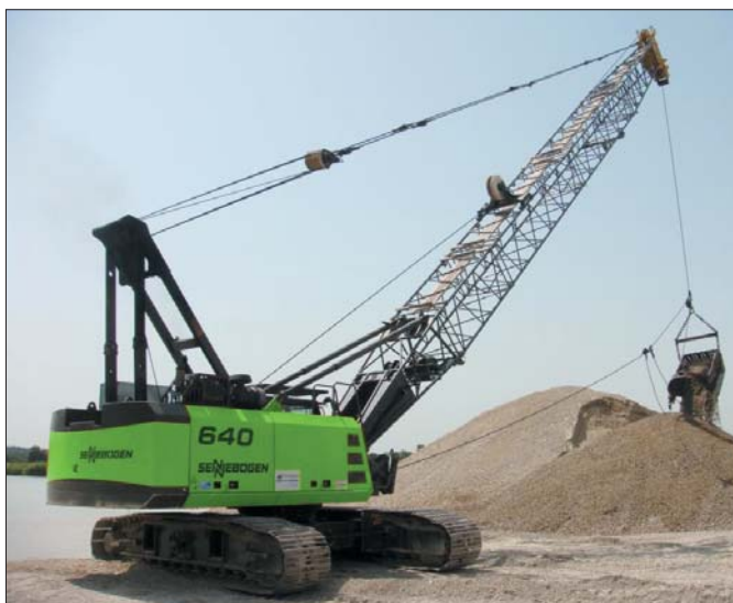
Czterdziestotonowa koparka linowa Sennebogen 640 w czasie pracy w żwirowni przy wydobyciu materiału z wody
