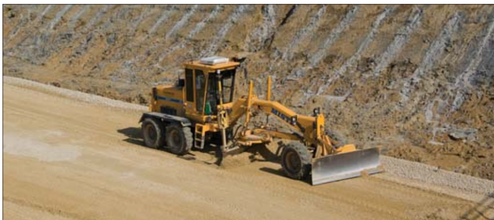
Pracująca na budowie odcinka autostrady A4 między Dębicą a Tarnowem równiarka Mista RD-165H wyposażona w system Trimble GCS900 3D pracujący w oparciu o aktywne lustro, tachimetr robotyczny oraz zestaw czujników
