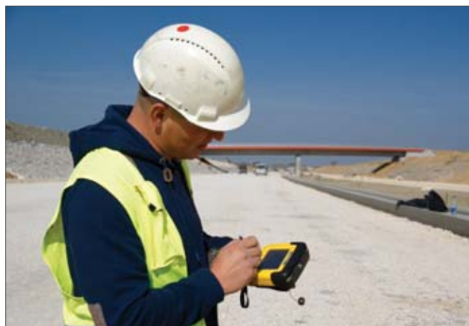
Geodeta Leszek Gomułka dokonuje inwentaryzacji prac na odcinku ciągu głównego autostrady. W ten sposób wyklucza zaistnienie najdrobniejszej pomyłki
