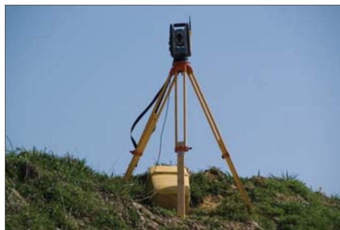
Operator maszyny otrzymuje informacje o aktualnej pozycji z umieszczonego w bezpiecznym miejscu tachimetru robotycznego
