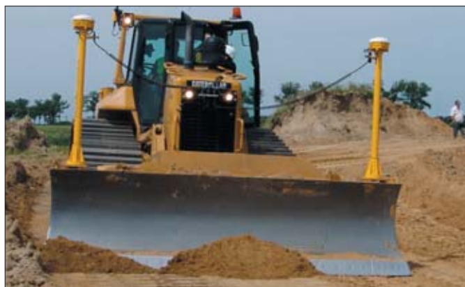
Na wykonanie zadania maszyna z systemem GCS900 3D potrzebowała niespełna półtorej godziny i zaledwie sześćdziesięciu przejazdów
