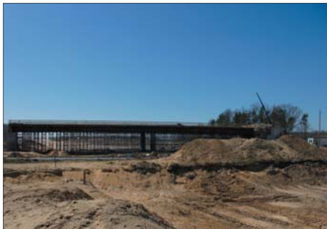
Powstająca droga stanowić będzie wschodnią autostradową obwodnicę Łodzi i umożliwi w przyszłości wyprowadzenie ruchu tranzytowego z centrum miasta
