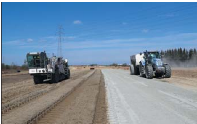
Ciągnik New Holland T6090 idzie „leb w leb” ze stabilizatorem gruntu. Do swojej rywalizacji maszyn doszło na budowie trasy Salomea-Wolica mającej „odkorkować” zatłoczoną Aleję Krakowską, Raszyn i Janki
