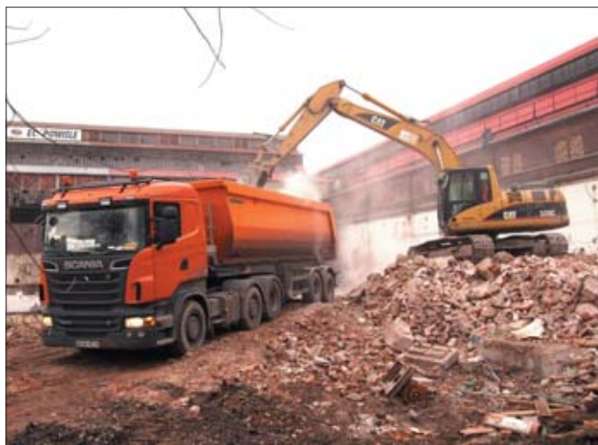
Odbiór urobku spod wyburzanego obiektu to jedno z najbardziej wymagających zastosowań opon budowlanych, bo w takich miejscach nie brakuje prętów wystających z podłoża czy ostrych kawałków gruzu
