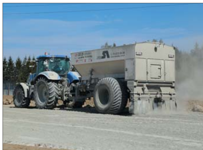
Podczas pracy z rozsiewaczem spoiwa, w tym przypadku cementu, najbardziej uciążliwe jest duże zapylenie. Mimo takich warunków, ciągniki New Holland nie wymagają specjalnych filtrów powietrza
