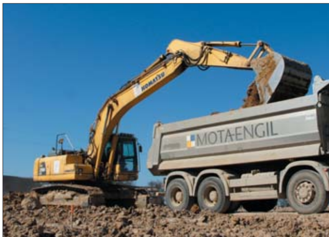
Koparki gąsienicowe Komatsu odgrywają kluczową rolę w pracach ziemnych na budowie drogi, która stanowić będzie wschodnią autostradową obwodnicę Łodzi
