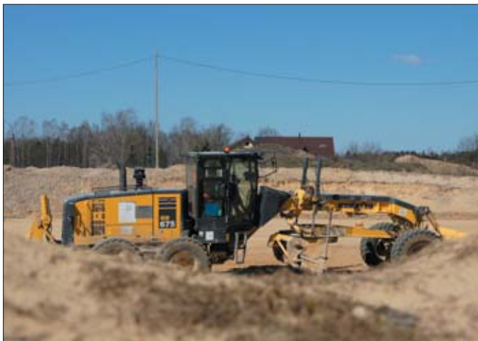
Na budowie autostrady A1 równiarki eksploatowane są w trudnych warunkach. Zależnie od pogody pracują w dużym zapyleniu lub grząskim terenie
