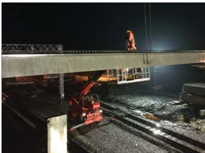
Ładowarka sprawdza się w warunkach placów budowy o mocno ograniczonej przestrzeni, choćby podczas wykonywania prac na szlakach kolejowych
