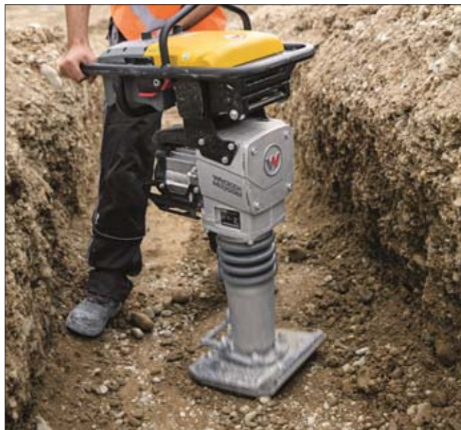
Ubijaki akumulatorowe Wacker Neuson pracują bez emisji spalin, dzięki czemu ich operator podczas pracy w wykopie nie jest narażony na szkodliwe wyziewy
