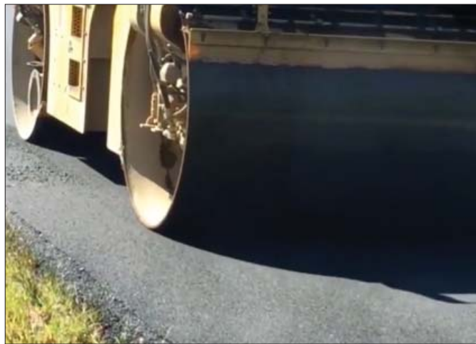
Układ oscylacyjny tylnego bębna sprawdza się na cieńszych warstwach mieszanki asfaltowej oraz na bardziej wrażliwych podłożach
