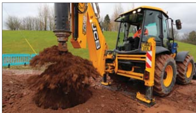
Mimo niewielkiej masy i zwartych gabarytów Pilingmaster jest bardzo wydajny, podczas dnia potrafi wywiercić nawet 150 metrów bieżących otworów
