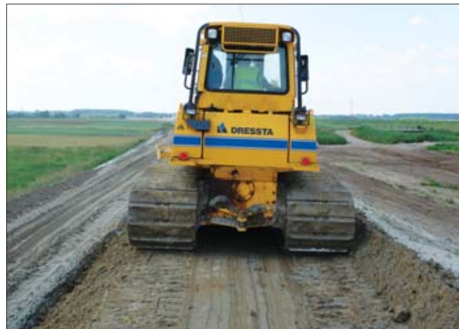
Prace ziemne prowadzone na wałach przeciwpowodziowych wymagają stosowania maszyn wywierających mniejszy nacisk na podłoże
