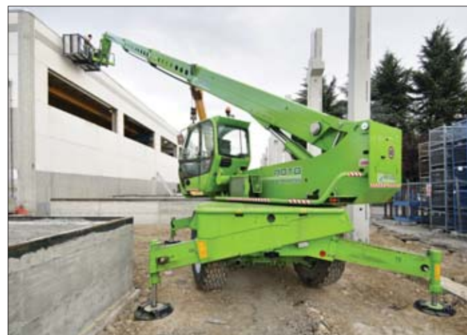
Możliwość skrzyżowania podpór stabilizujących w istotny zwiększa zasięg punktów podparcia, a tym samym bezpieczeństwo na placu budowy
