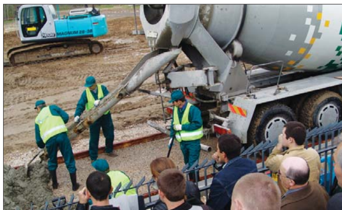
Na tyłach hal targowych odbywały się prawdziwe pokazy, maszyny kopały, ładowały, budowano także drogę betonową. Też śledziły to tłumy...
