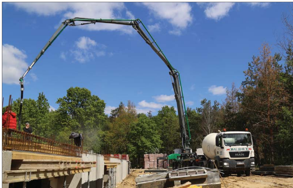
Samochodowa pompa do betonu Liebherr THP 140 37 XXT jest niezwykle efektywna i wydajna. Zaawansowane technologicznie urządzenie pozwala dostarczyć ciekły beton do trudno dostępnych miejsc w sposób szybki i w pełni bezpieczny
