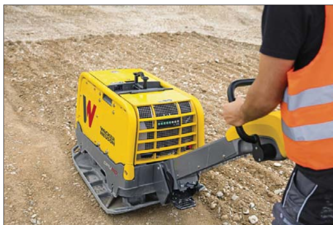
Płyta wibracyjna wyposażona w układ Compamatic wysyła na serwer systemu telematycznego EquipCare dane pozwalające kontrolować jakość zagęszczenia
