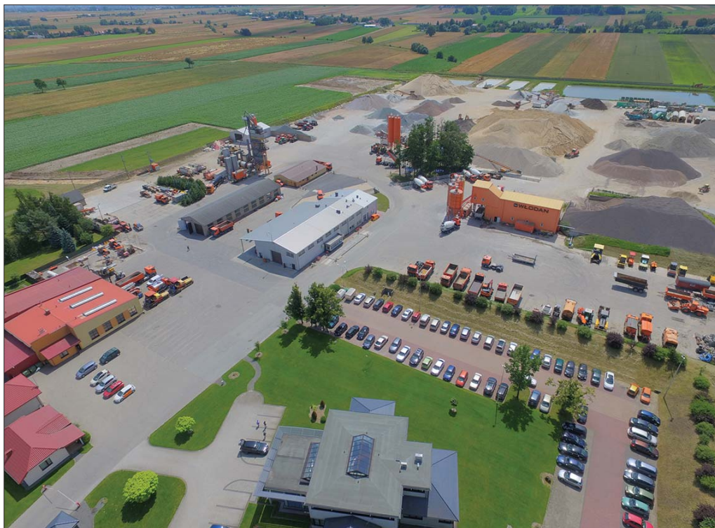
Początkowo działalność firmy WŁODAN ograniczała się do transportu i naprawy nawierzchni drogowych. Dziś firma przekształciła się w wykonawcę dużych projektów dysponującego specjalistycznym zapleczem produkcyjnym oraz odpowiednim parkiem maszynowym
