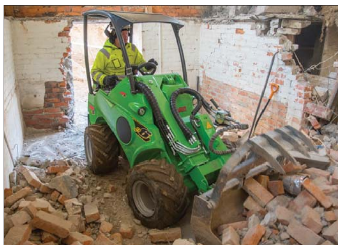
Ładowarki Avant doskonale sprawdzają się także podczas wyburzeń i szeroko pojętych prac rozbiórkowych wewnątrz budynków
