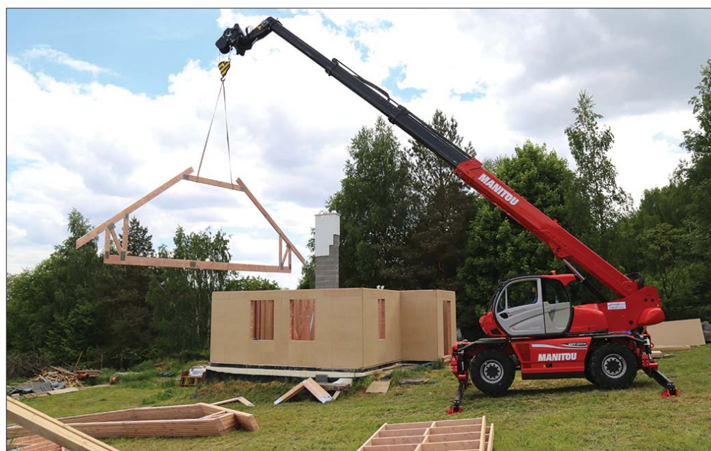
Wykorzystanie ładowarki teleskopowej do budowy domu z gotowych elementów sprawia, że na osiągnięcie stanu surowego potrzeba zaledwie kilku dni. Później maszyna znajduje zastosowanie w pracach instalacyjnych i wykończeniowych
