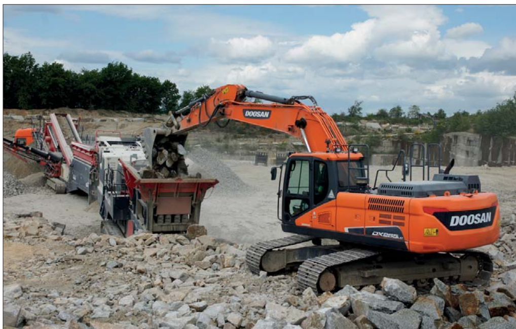
Koparka uzbrojona w specjalistyczną, specjalnie wzmocnioną łyżkę wyprodukowaną przez Dekpol Steel może stanowić niezawodne ogniwo łańcucha technologicznego kopalni dotyczącego procesu segregacji granitu
