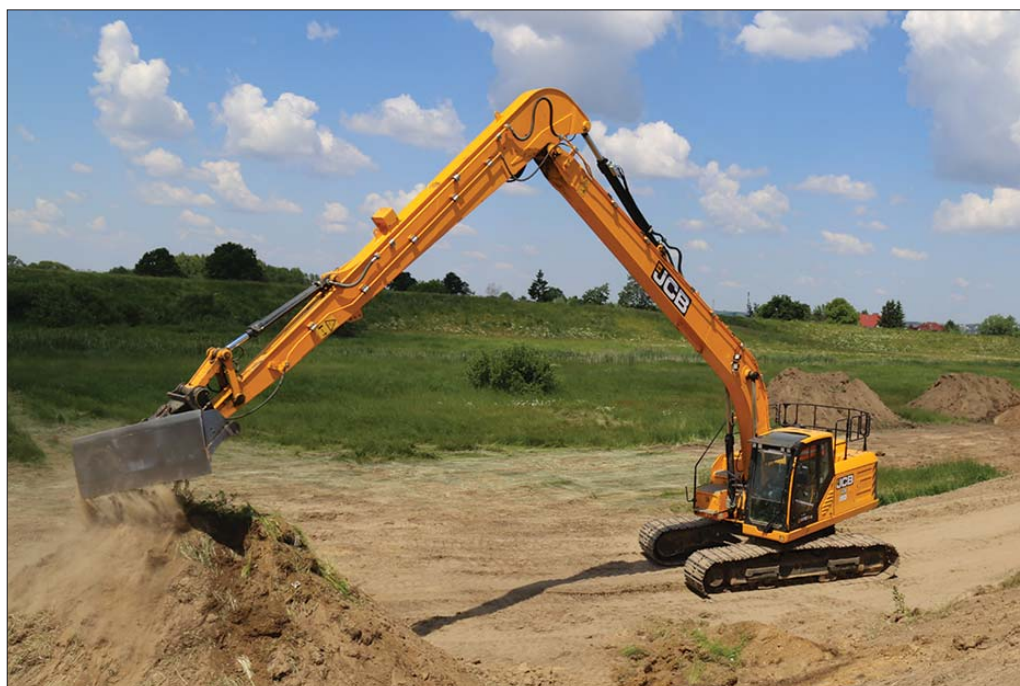
Pierwsza w Polsce koparka JCB Serii X trafiła do Zakładu Usług Wodno-Melioracyjnych i Rekultywacji w Sandomierzu. Dziś firma ma pięć takich maszyn, w tym dwie wyposażone w specjalistyczny wysięgnik Long Reach
