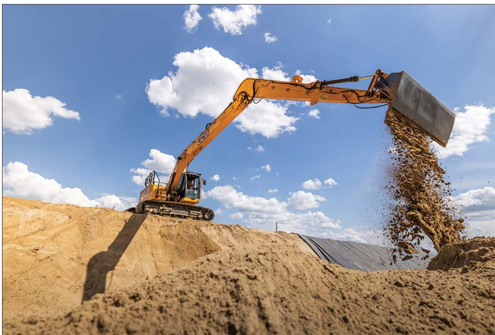
Podczas pracy na wałach przy formowaniu tak olbrzymi zasięg jest wprost nieocenioną zaletą koparki. Pozwala profilować zbocze od dołu do góry za jednym pociągnięciem, bez poprawek, co znacznie przyspiesza wykonanie zadania
