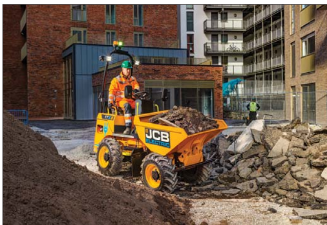
Elektryczne miniwozidło doskonale sprawdza się w strefach wrażliwych na emisję zanieczyszczeń i hałasu, jakimi są na przykład miejskie place budowy
